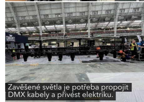
Hotový rig se pomocí motorů zvedne do požadované výšky.
